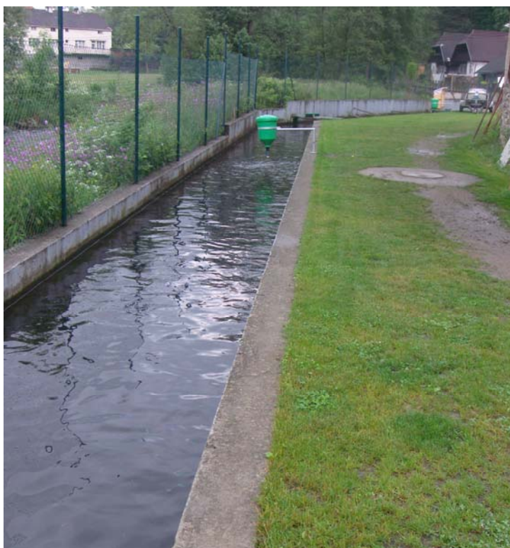
Obr. 9.: Pohled na přímo sousedící průtočný žlab.
