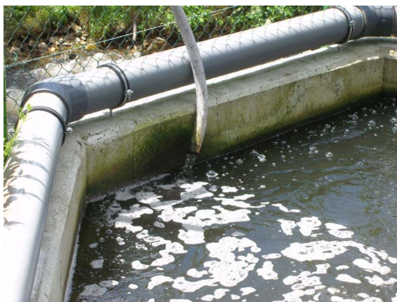
Obr. 3.: Přítok drenážní vody do systému, jediného zdroje vody pro celý recirkulační systém.
