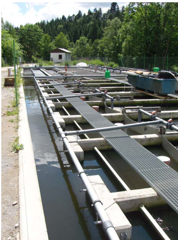
Obr. 6.: Pohled na recirkulační systém dánského typu, vpředu odchovná část, vzadu biofiltr.
